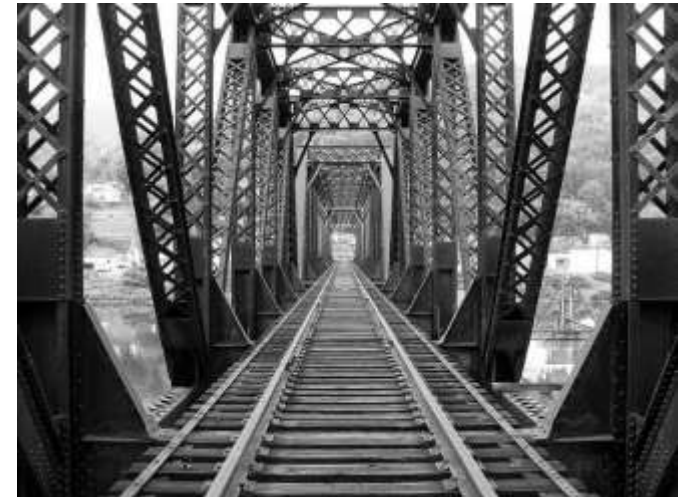
puente del ferrocarril, pistas, rieles, cerchas, triple estilo pratt, planchar, perspectiva, transporte, ver, formas, estructura | Pixist
