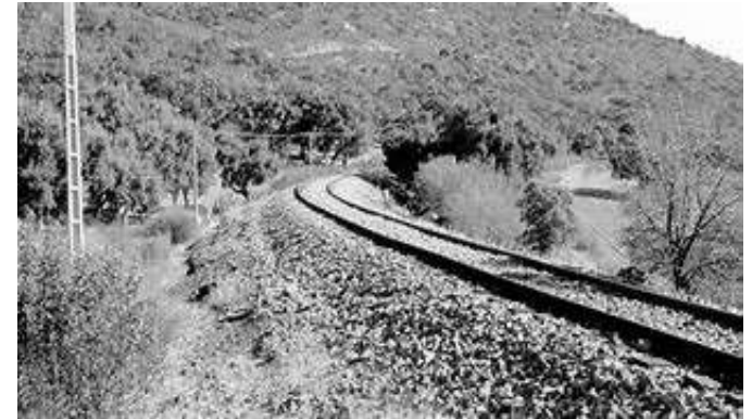
Tratamiento de terraplenes y permeabilización transversal de plataforma - Ines Ingenieros
